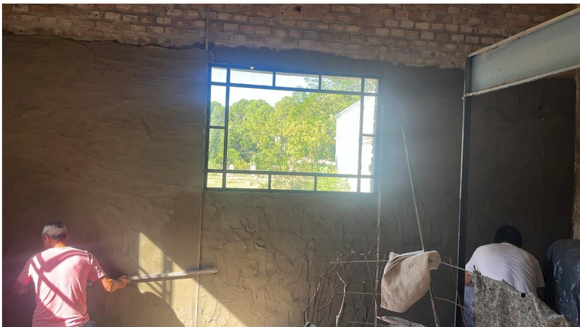
Revoque de paredes en ampliación de la Biblioteca popular Amanecer Arroyo Leyes.
