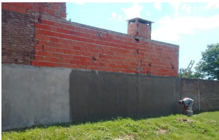
Trabajos de albañilería en la Asociación Deportiva y Social Loyola
